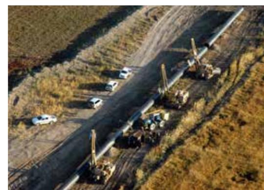
• Above: Installation of the pipeline "Turkmenistan - China". • Yıkarda: "Türkmenistan - Hytaý" gaz geçirijisi. • Выше: Газопровод «Туркменистан - Китай».
